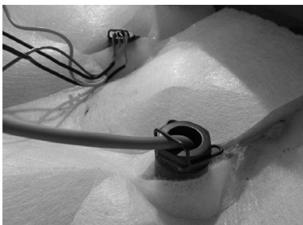
Fig. 16 – imaginea senzorului de temperatură a apei TV în recipientul cazanului tip DxxP
