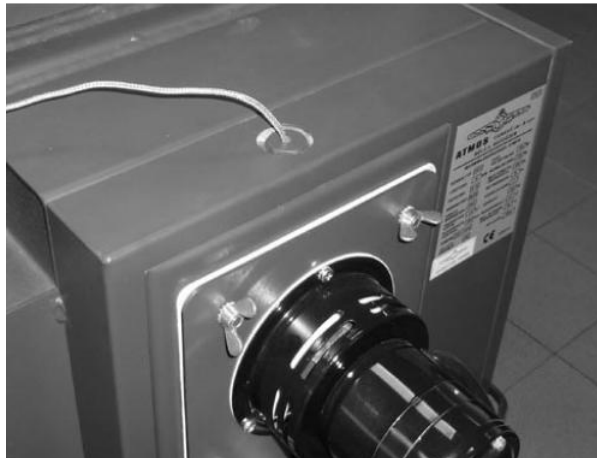
Fig. 14 – imaginea senzorului de gaze de ardere TS în recipientul canalului de fum
