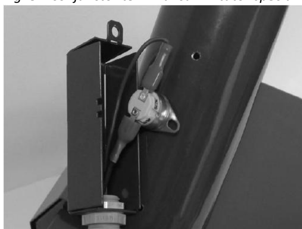
Fig. 10 – termostat de siguranță 95°C pe conducta de alimentare cu peleti
