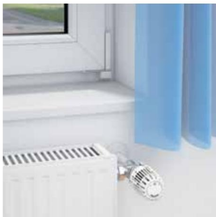
Corecta Circulația aerului în jurul termostaticului capul nu este împiedicat.
